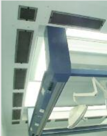
Abluft-Kombination von Weiss. Eingebaut im neu entwickelten umlaufenden Absaugring (Deckenversion)
