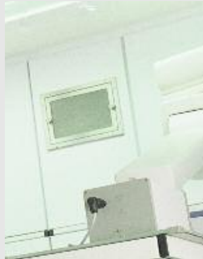
Die neue Abluft-Kombination von Weiss. Integriert in die OP-Wand (Wandversion)
